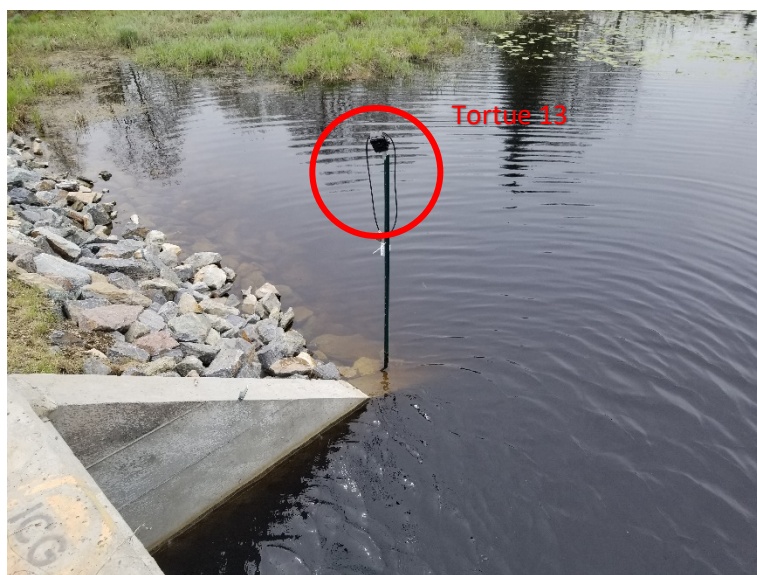
FIGURE 34. CAMÉRA « TORTUE 13 » POSITIONNÉE SUR UN PIEU, À L'ENTRÉE OUEST DU PASSAGE AQUATIQUE
