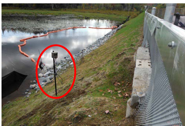
FIGURE 18. CAMÉRA « TORTUE 12 » À L'ENTRÉE EST DU PASSAGE TERRESTRE
