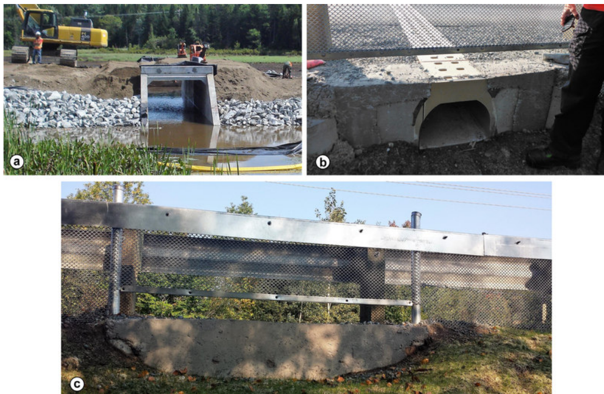
FIGURE 1. PHOTOGRAPHIES DU PASSAGE À TORTUES DE LA ROUTE 245 À BOLTON-EST : A) PONCEAU PRÉFABRIQUÉ EN BÉTON; B) TUNNEL PRÉFABRIQUÉ EN BÉTON POLYMÈRE; C) CLÔTURE DE DÉVIATION ET ÉCHAPPATOIRE.
